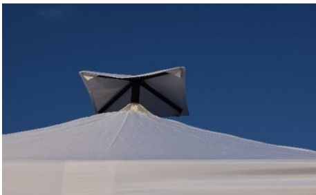
Dach mit Luftabzug
